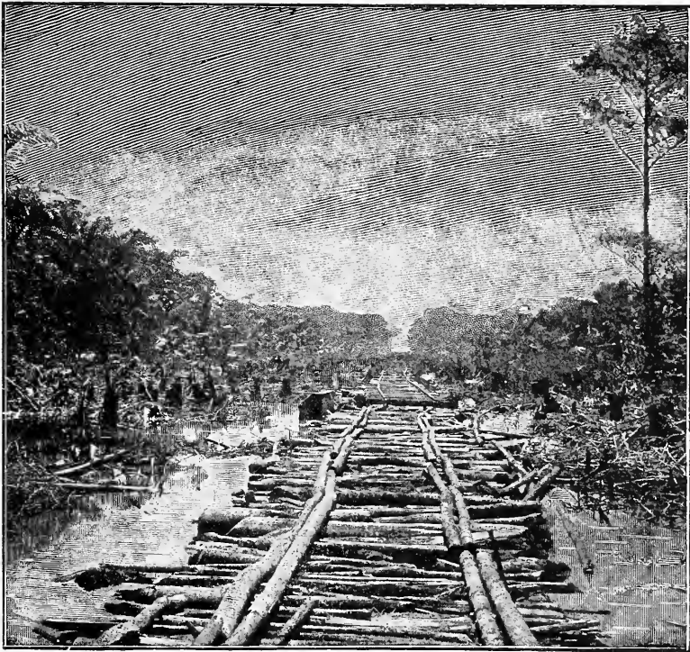
Bau der Eisenbahn durch den Sumpf.
